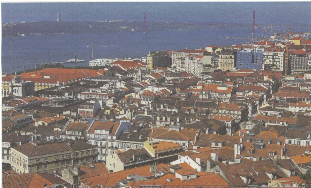
Em Lisboa basta estar maré cheia no Tejo para o escoamento de água não funcionar
